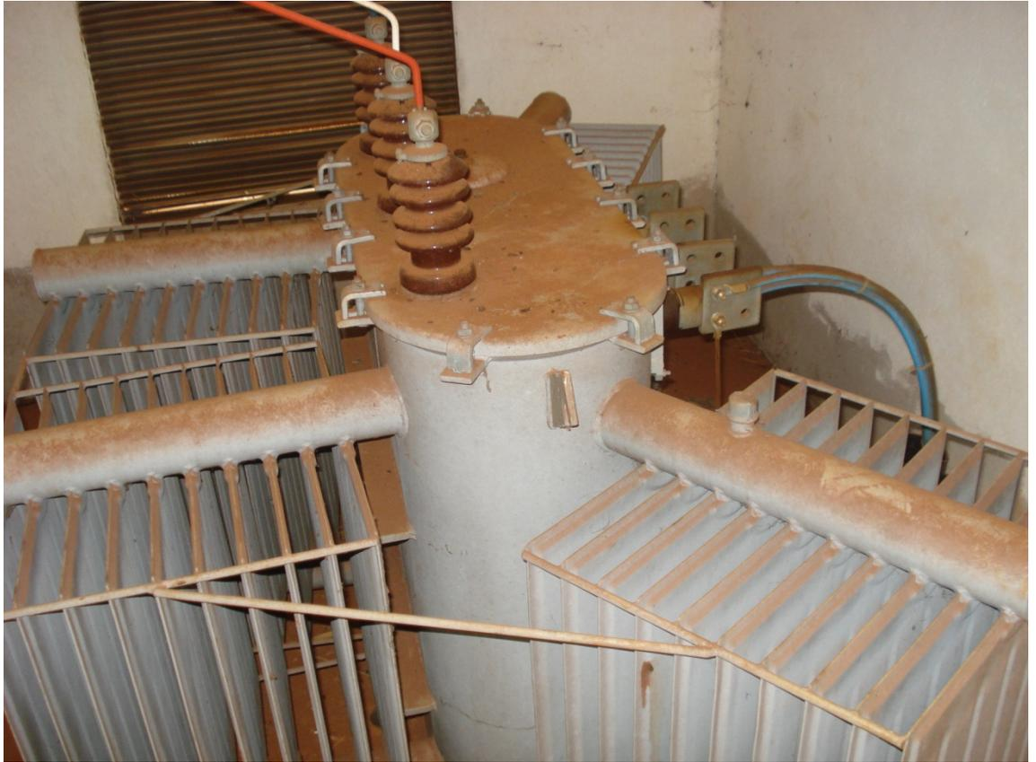
**TRANSFORMADOR DE 500 KVA COMPLETO COM QUADRO DE COMANDO
